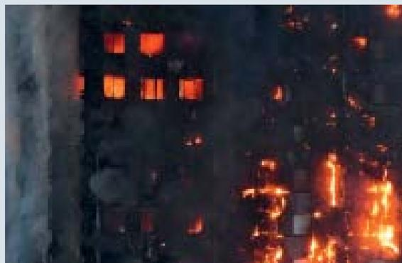
Lokales Nachbrennen der PU-Dämmung nach Durchzug der Flammenfront
